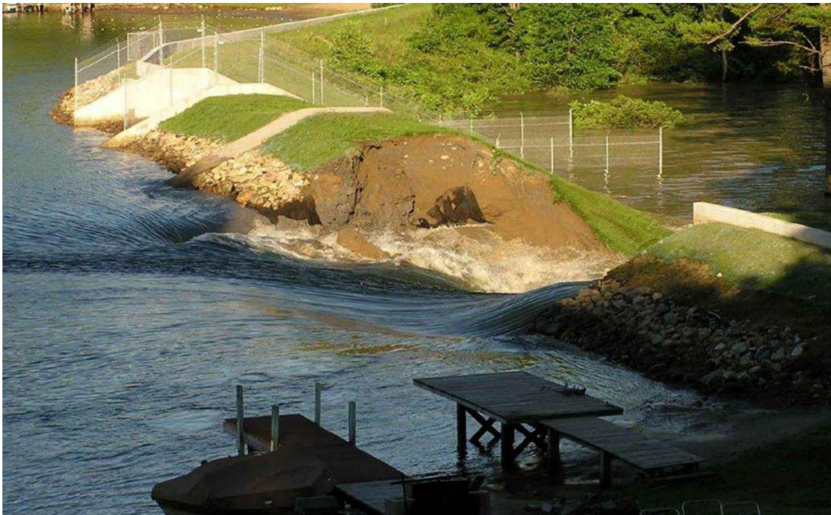
Fluxo através da brecha em barragem de terra.
